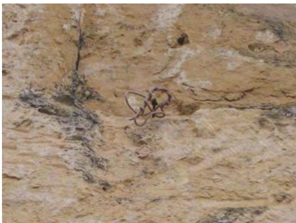
Figura 13. Fotografia digital aproximada do detalhe da fachada principal da Igreja da Sé.
