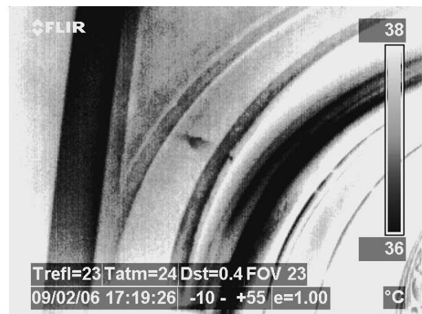
Figura 9. Termograma de detalhe da porta principal da Igreja da Sé.
