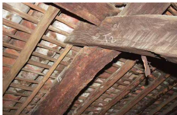
Fig.4 vista parcial da estrutura secundária da cobertura da Igreja de N. Sª. das Fronteiras/Recife (caibro roliço e ripa de imbiriba). Foto da autora. Setembro/2002.
