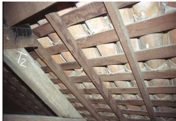
Fig.5 vista parcial da estrutura secundária da cobertura da Igreja de N.Sª. da Conceição da Congregação Mariana/Recife (caibro serrado e ripão). Foto da autora. Outubro/2002
