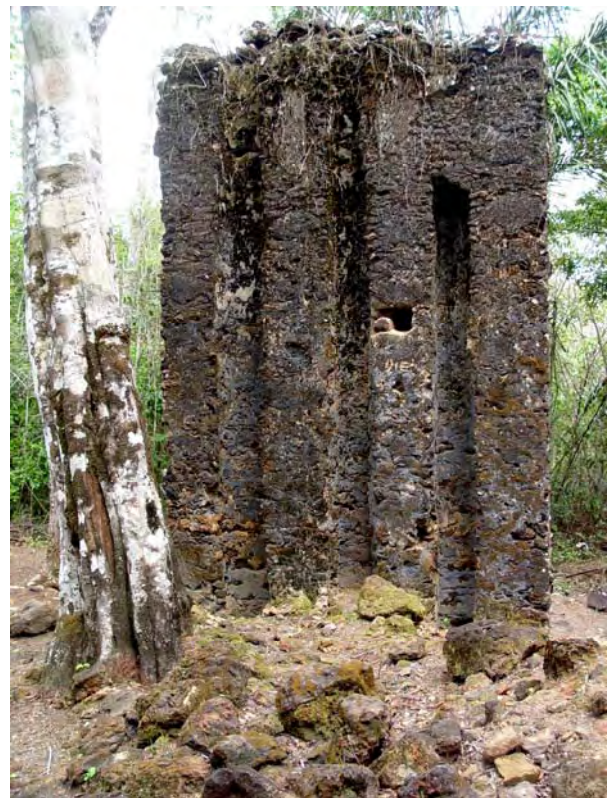
Figura 11 - Marcas deixadas nas paredes que permaneceram em pé, pelos esteios incrustados em seu interior.
