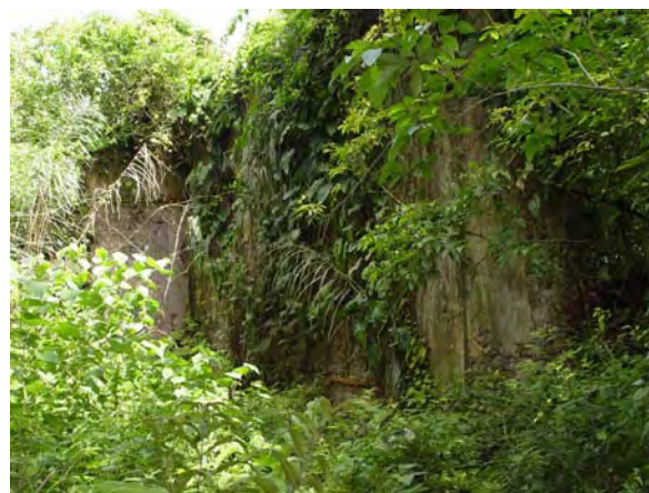
Figura 18 - Paredes em pedra
