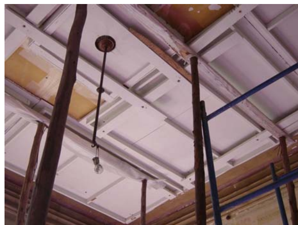
Fig. 01 – escoramento do forro do mezanino da Vila Penteado (foto: Antônio Sarasá)
