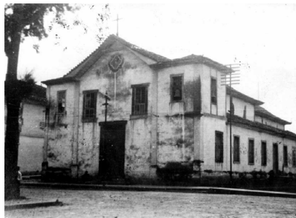
Fig. 08 Vista geral da Igreja do Rosário no início da década de 1930. Utilização de foto de época para elaboração do Diagnóstico retrospectivo: Presença de manchas, desprendimento de reboco e apodrecimento de peças de madeira na Fachada Leste, provocados por infiltrações. Telhas soltas, deslocadas e/ou quebradas (FONTE: Museu Bi Moreira – Foto 2.620, cc. 1930).
