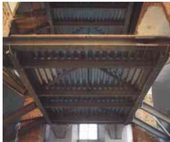
Fig.1 – Exemplo de inserção executada em obra de consolidação na Faculdade de Economia e Comércio em Torino. (MAZZOLANI, 1991. p. 7).
