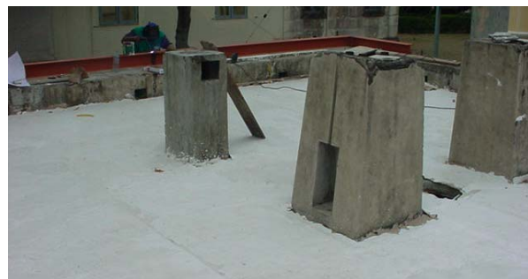
Fig. 2 – Piso protegido com gesso, 2005 (Fonte: Arquivo MAST).
