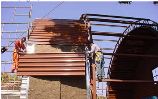
Fig. 5 – Fixação das telhas termo-acústicas, 2005 (Fonte: Arquivo MAST).
