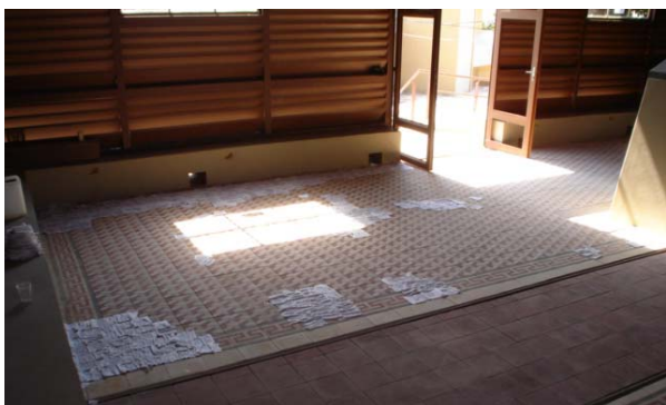
Fig. 3 – Aplicação de solução com emplastro no ladrilho hidráulico (Fonte: Arquivo MAST).
