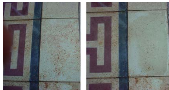
Fig. 4 – Antes e depois da aplicação do ácido oxálico (Fonte: Arquivo MAST).
