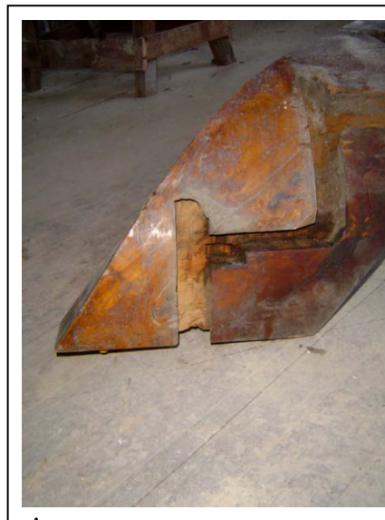
Figura 7: Trecho de banzo em curva.
