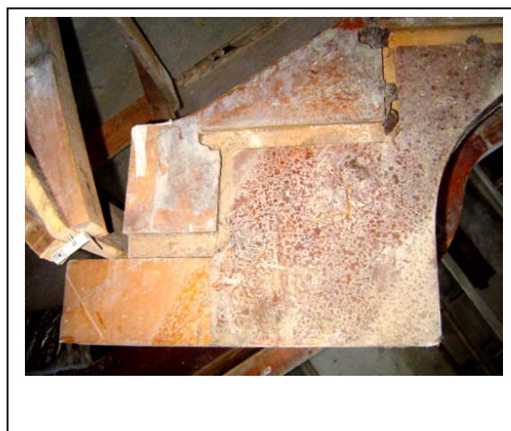
Figura 8: Trecho curvo de banzo, referente ao encaixe do degrau de convite.
