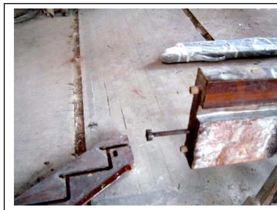
Figura 4: Sistema de encaixe das peças que formam os banzos da escadaria.
