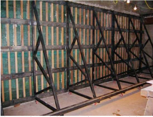
Figura 6: O mural, já com o sistema estrutural de sustentação instalado.
