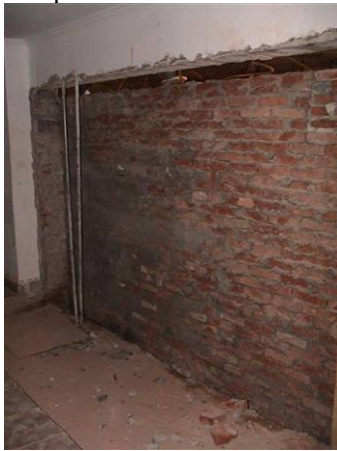
Figura 7: Vista da alvenaria de sustentação (atrás do mural)
