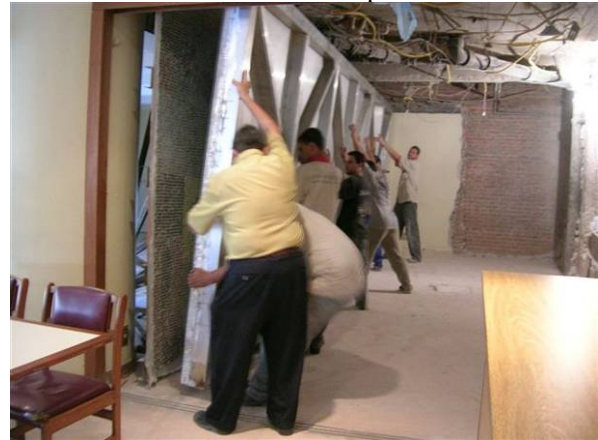
Figura 9: Posicionamento da nova base de suporte.
