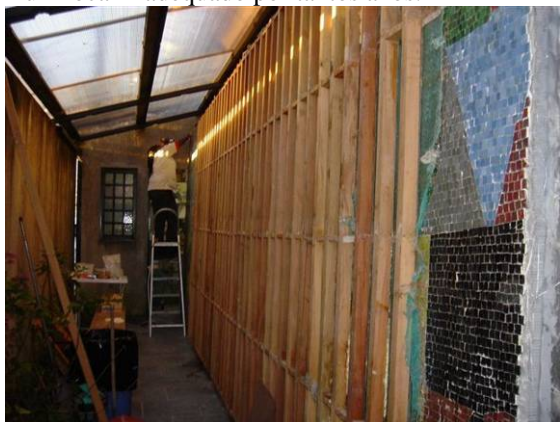
Figura 10: remoção de entelamento frontal e limpeza final já no Atelier Sarasá.
