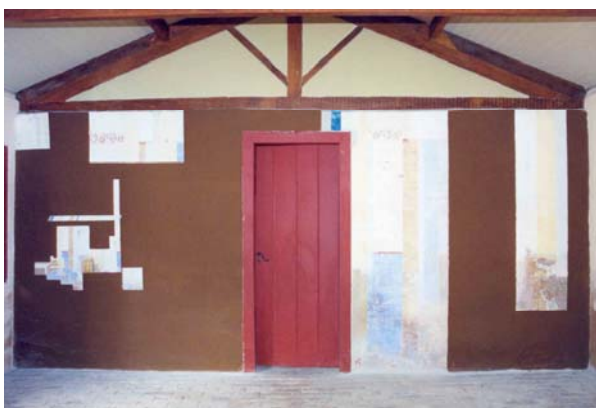
Figura 04: Prospecções e testemunhos da sala 07.
