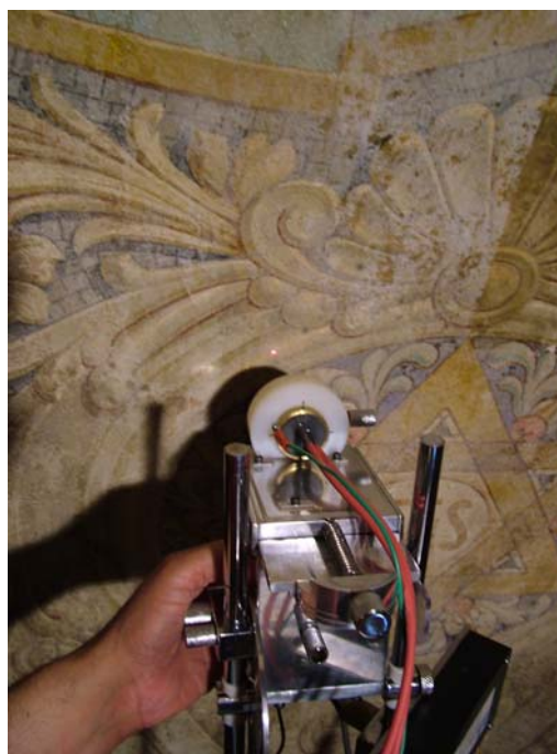
Fig.2 O sistema portátil de EDXRF posicionado para a medida de uma região da pintura mural na parede com infiltração.
