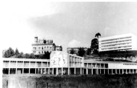
Fig. 1 Vista panorâmica de parte do NAHM com Pav. Arthur Neiva em primeiro plano. Déc 1950.
