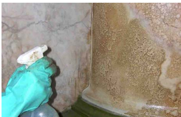
Fig.10: Borrifamento de acetona sobre glaze espalhado com esponja.
