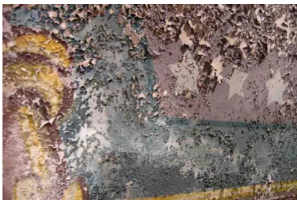
Fig.08: Descolamento generalizado da película pictórica e presença de cristais de sais na superfície da pintura.
