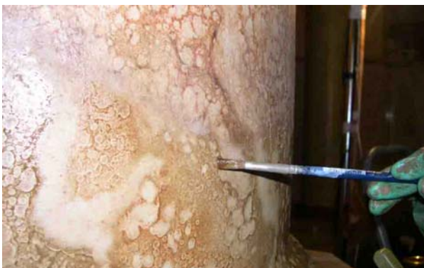
Fig.11: Retoque e desenho de veios com pincel.
