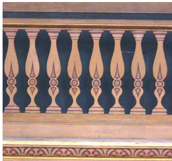
Fig. 10: Balaustrada após intervenção de restauro.
