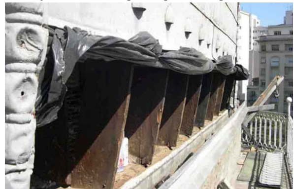
Fig02: Madeiramento da calota externa.
