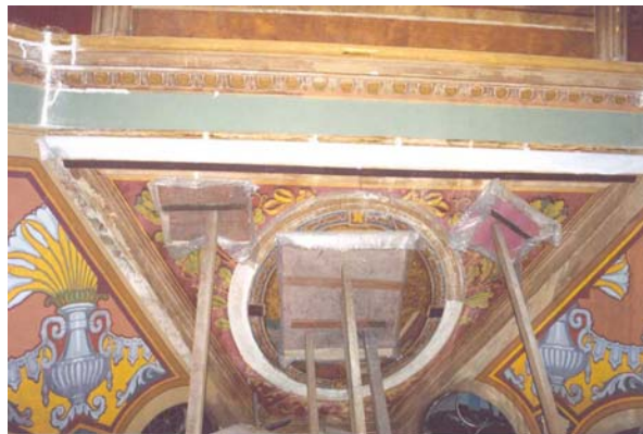
Fig.06: Escoramento dos painéis durante processo de instalação dos tirantes (cabos de aço e cintas).
