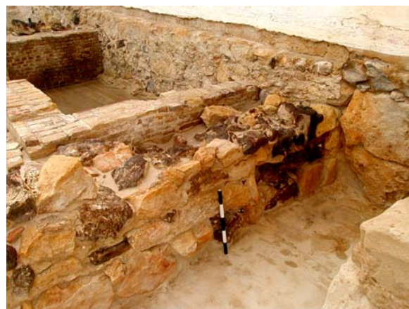
Figura 4 - Observe-se a diferença entre a parede interna em tijolos, e em pedras na área e externa da casa de pólvora.
