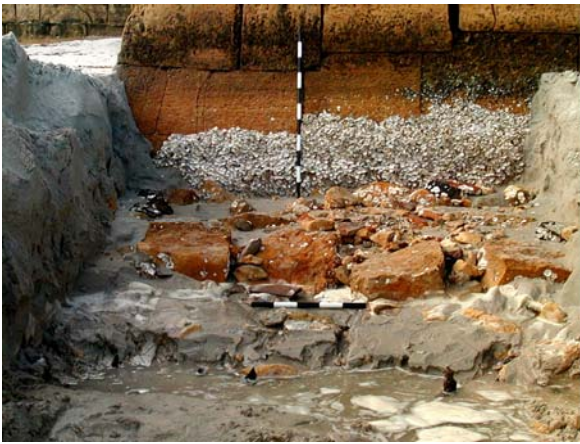
Figura 11 - A presença de ostra aderida à parede do Forte, revela que o mar chegou a atingir suas muralhas.
