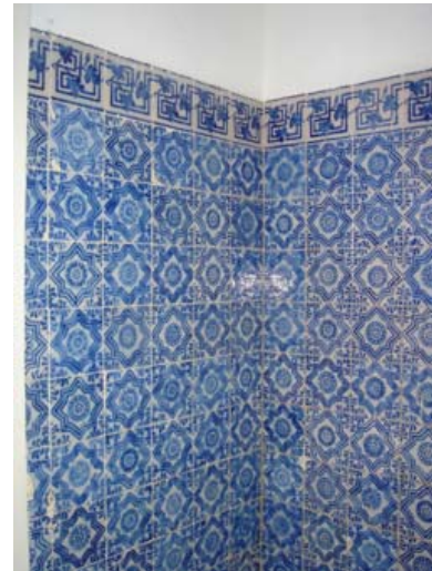
Figura 11 – Paredes internas revestidas de azulejos em sala de professores, 2005.
