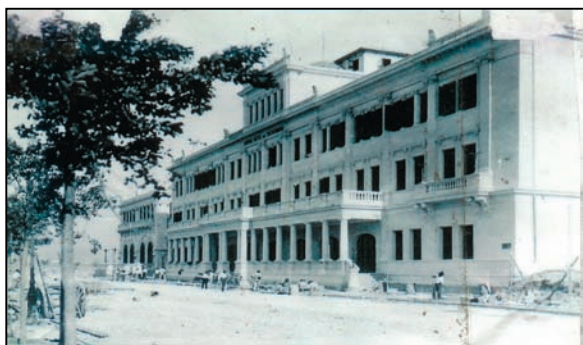
Fig.1 Hotel Sete de Setembro em construção.
