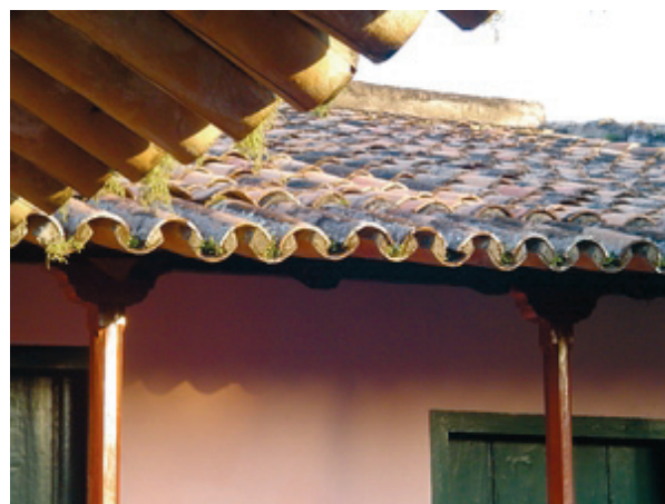
Fig.1 Telhado do alpendre do sobrado nº 4, da Praça da Aclamação, em Cachoeira (BA), sede do IPHAN – foto do autor 2005.
