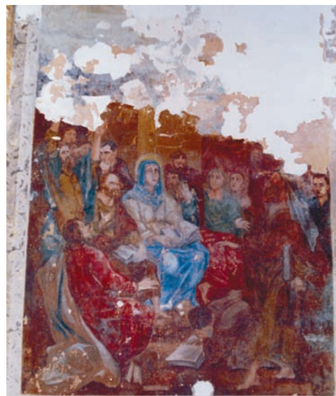
Fig.1 Vista Frontal: Remoção de camadas sobrepostas
