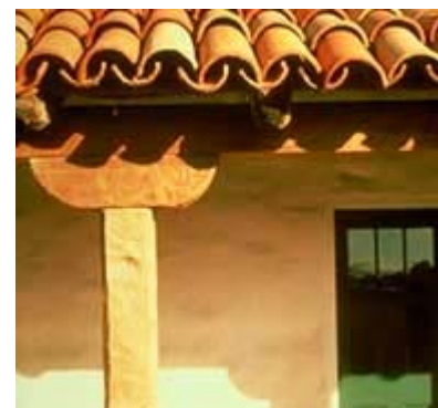
Fig.3 Aspecto do telhamento com único formato de telha.
